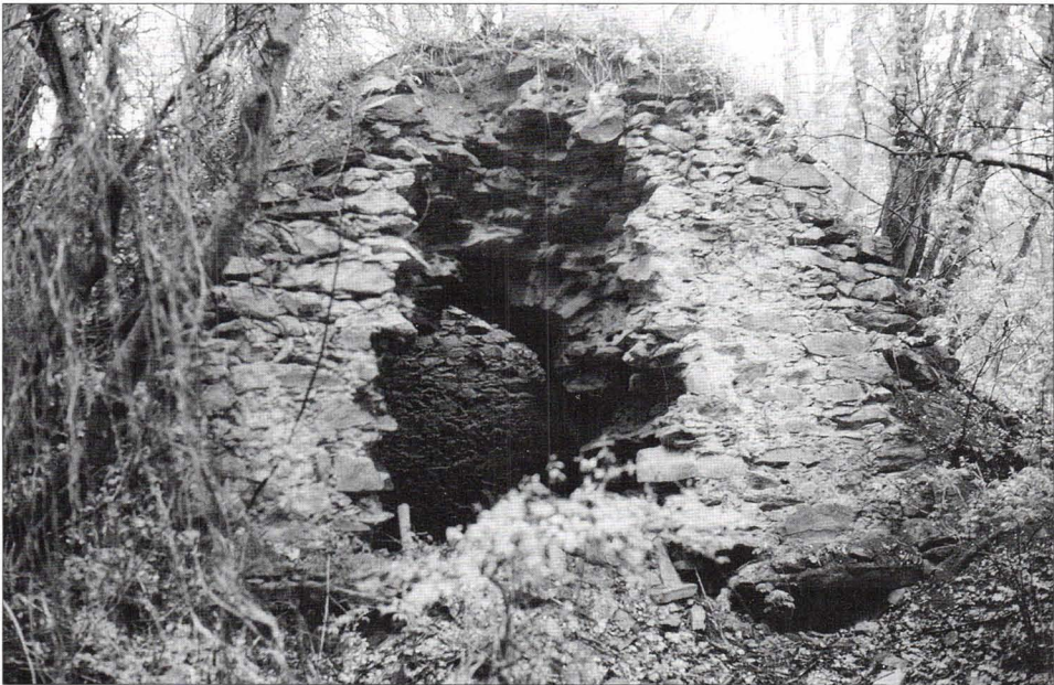
Meilerartiger Ziegelofen in Engelsdorf
