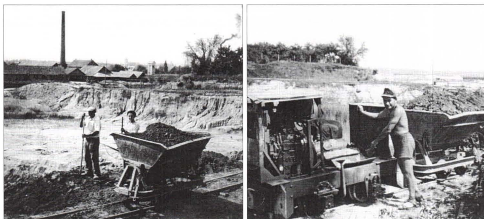
Ziegelwerk Thallhammer: Lehmgewinnung
