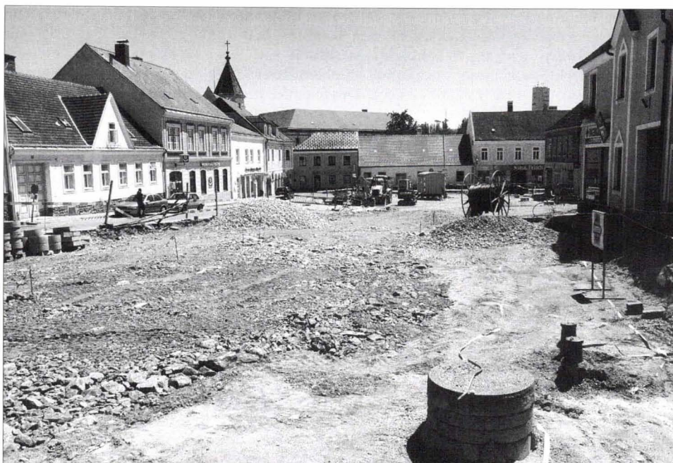
Umbau des Neuen Marktes in Zwettl, Juli 1999 (Foto: Stadtarchiv Zwettl)
