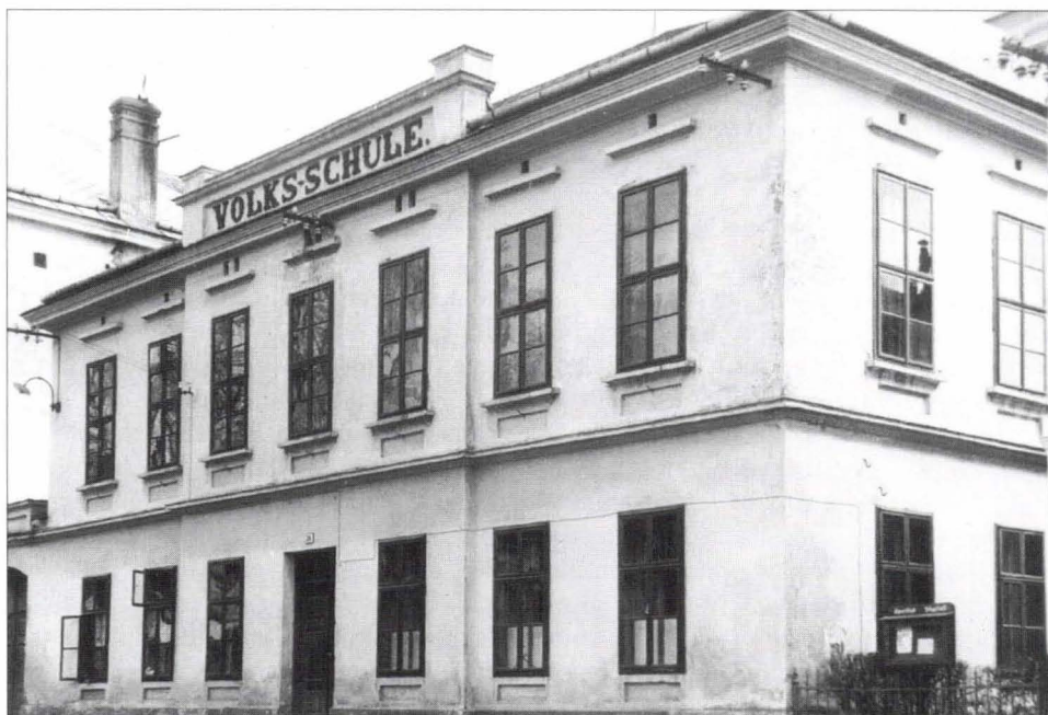
Drittes Pöggstaller Schulhaus (1877-1958)
