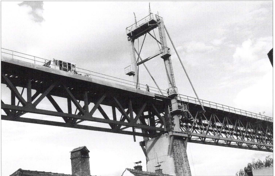
Erneuerung der Zwettler Eisenbahnbrücke
