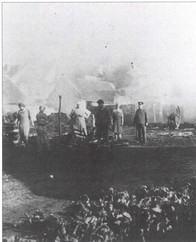
Abb. 22: Brandstätte der Wirtschaftsgebäude der Häuser Nr. 7, 8, 9 und 10, August 1944
