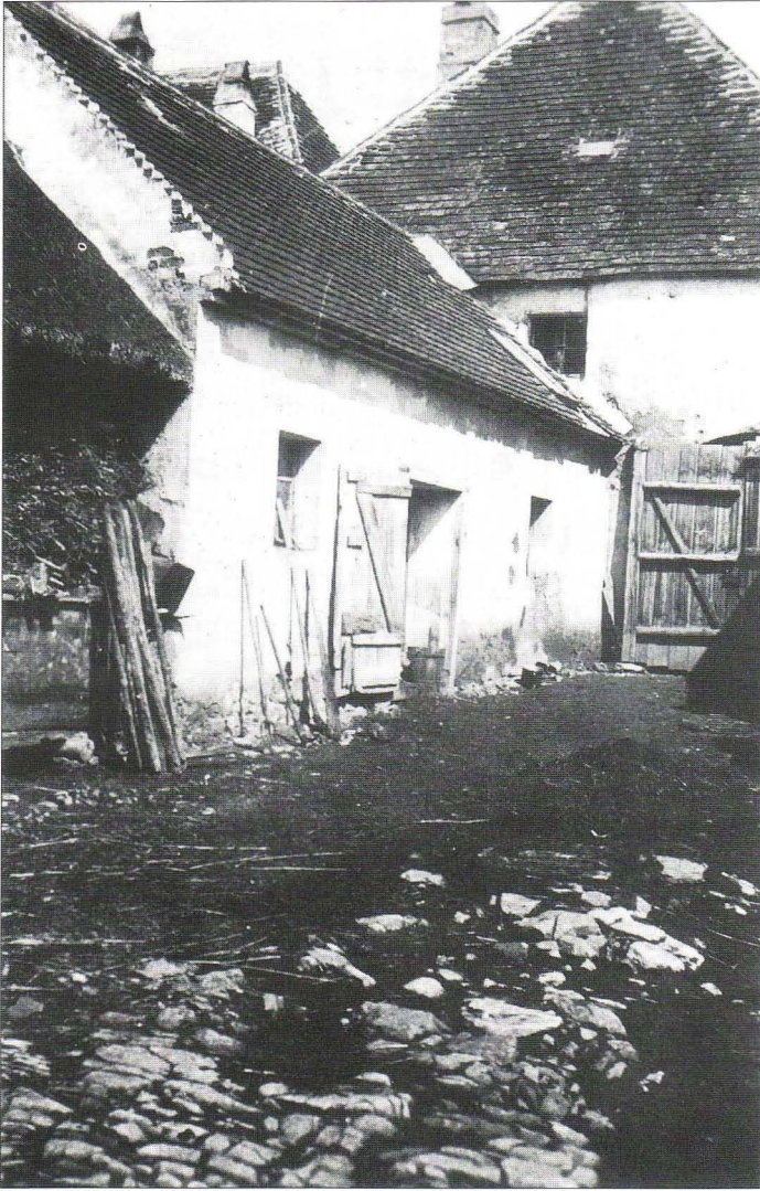
Abb. 1: Blick in den Hof des Hauses Nr. 10, Mai 1944, Foto von Thea Widhalm
