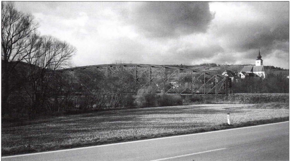
Kampbrücke bei Stiefen
