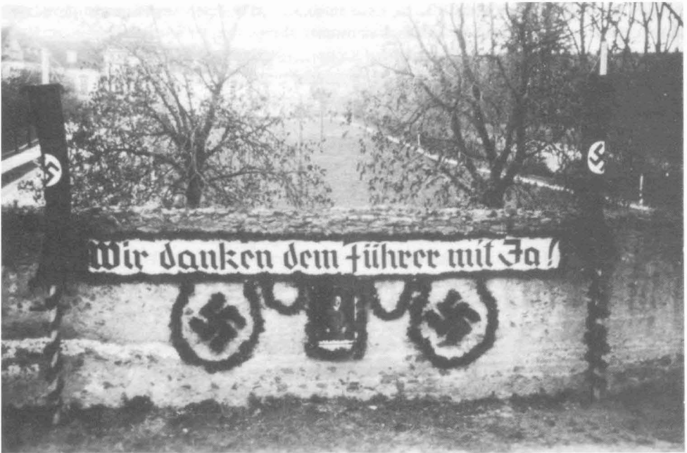
Immer wieder prangten propagandistische Parolen in großen Lettern gekoppelt mit Hitlerbildern und dem Hakenkreuz von Hausfassaden und Mauern. Dieses Bild zeigt die Begrenzungsmauer des Stiftes wenige Tage vor der Volksabstimmung.
