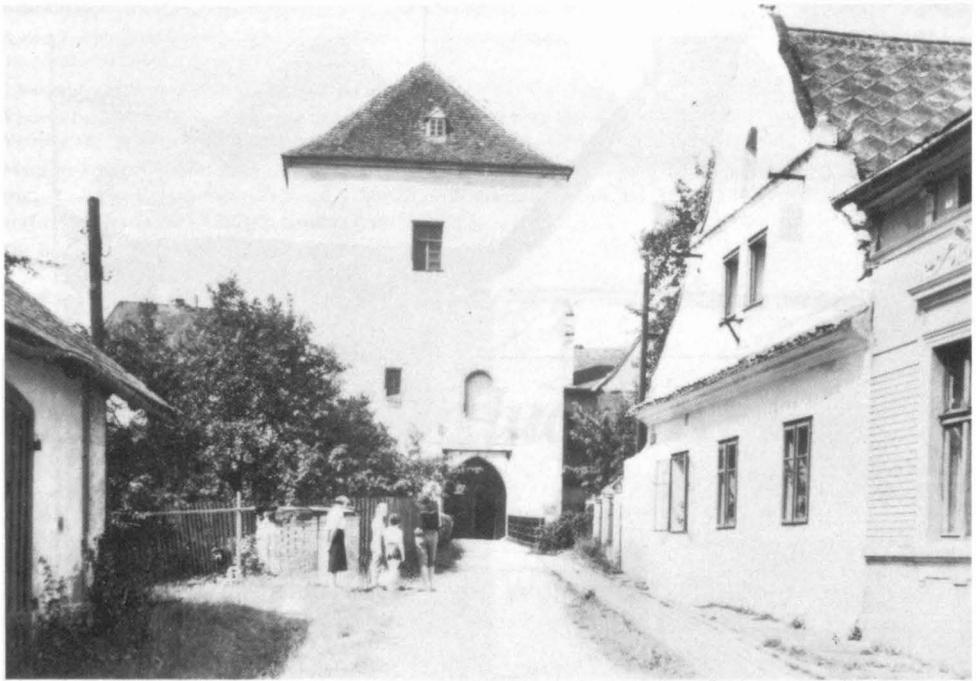
Das Bild zeigt den Haupteingang in die Gratzner Burg, vom Hauptplatz kommend. Die Sage erzählt, daß im oberen großen Fenster des Archivturmes häufig die Weiße Frau zu sehen gewesen sei.
